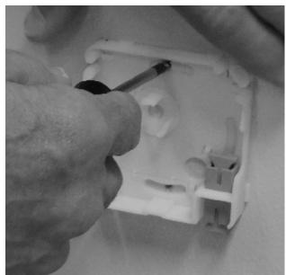
1. AWAY FROM WALL STUDS, USE THE EO MODULE BASE AS A TEMPLATE. MARK THE WALL USING A PHILLIPS #1 SCREWDRIVER (~5MM OD SHAFT)
